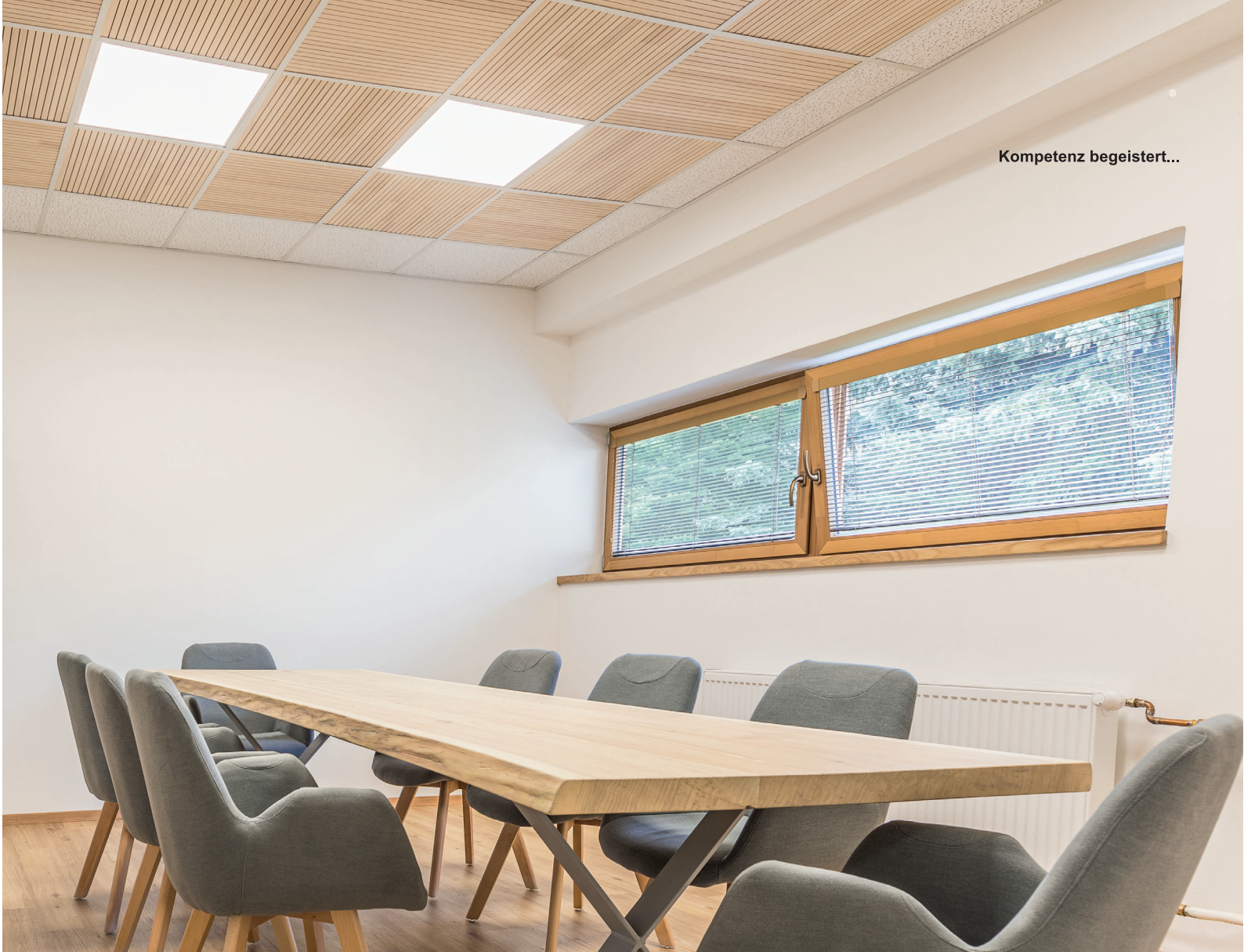
Weißtanne-Einhängeakustikkassetten mit abwechselnd versetzten Akustiknuten und weißer Umrandung.
