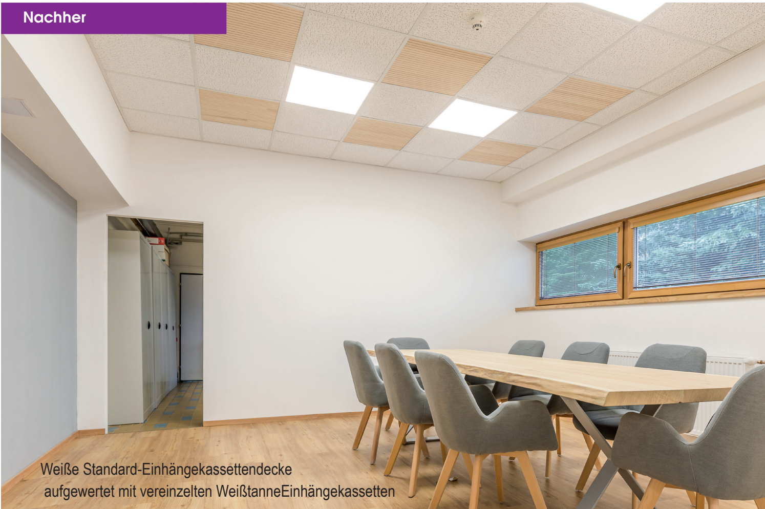
Weißtanne Akustik-Einhängekassetten mit abwechselnd versetzten Akustiknuten, weißer Umrandung und mittigem Akustiksegel
